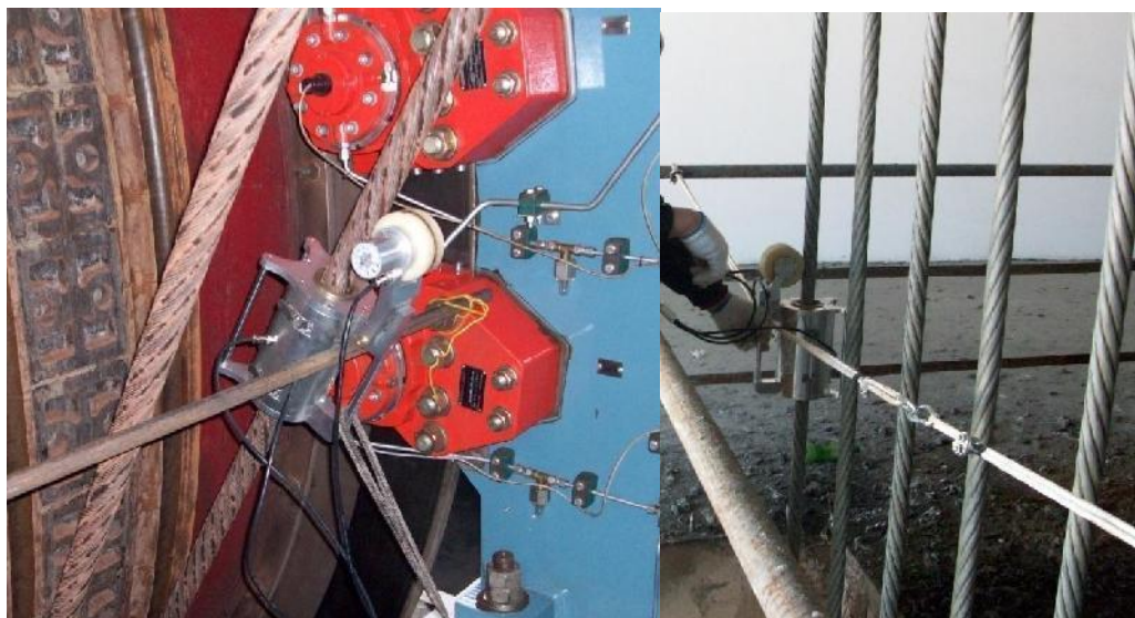
矿用提升检测现场
